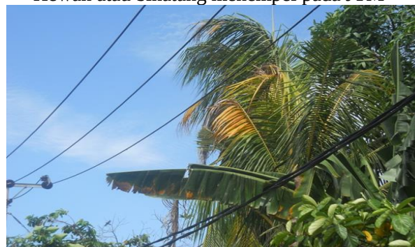
Gambar 1. Foto Pohon yang mengenai Jaringan Sumber : Irwan Wahyudin (2007) 12
