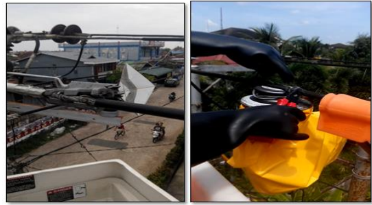
Gambar 18. Membersihkan Kawat Layang-layang
