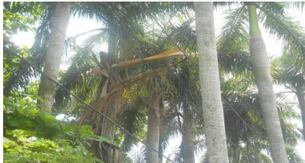
Gambar 2. Foto Pohon yang menempel Jaringan SUTM Sumber : Irwan Wahyudin (2007) 12
